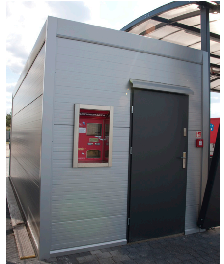
Rozmieniarka banknotów zamontowana w podstawo- wym kontenerze technicznym
